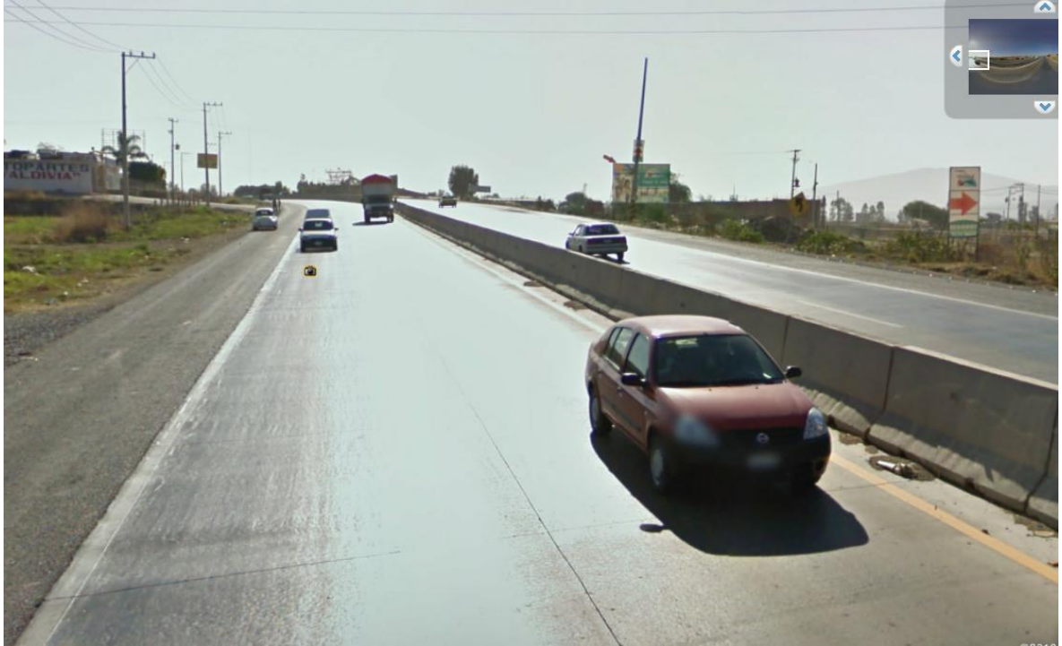
Vista de vialidad Regional Carretera Libre a Los Altos.
