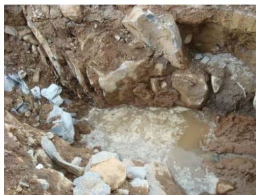
Vista de problemas de agua estancada por falta de drenaje.
