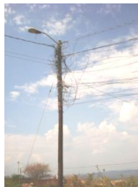
Vista de tomas ilegales en zonas carentes de servicio de energía eléctrica.
